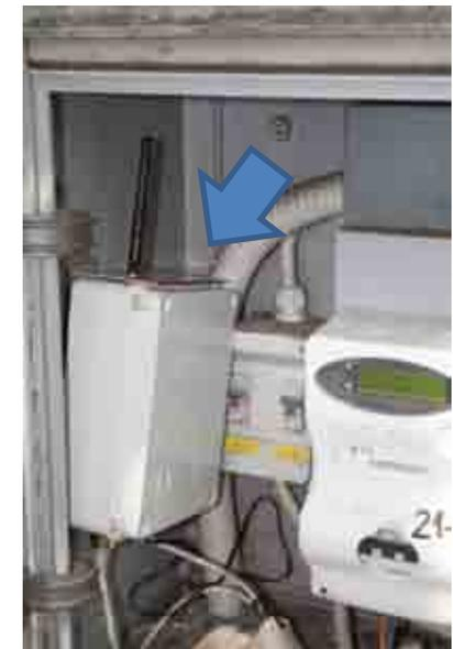
Il Comune di Trento sta fungendo da «testbed» per il sistema Picinque. Alcune linee di lampioni sono state dotate di «Box Picinque». Il coordinatore, alloggiato nei quadri preesistenti (foto a destra), governa la rete, coordina il funzionamento dei lampioni e invia i dati al server centrale.
