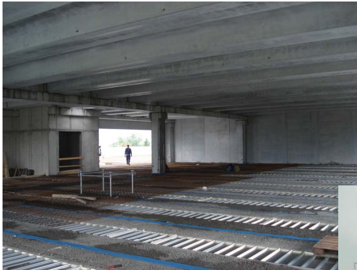
>> Foto 9: Realizzazione solaio piano terra – 12/05/2011
