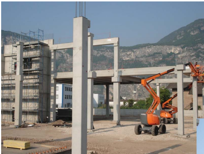
>> Foto 5: Posa pilastri – 22/04/2011
