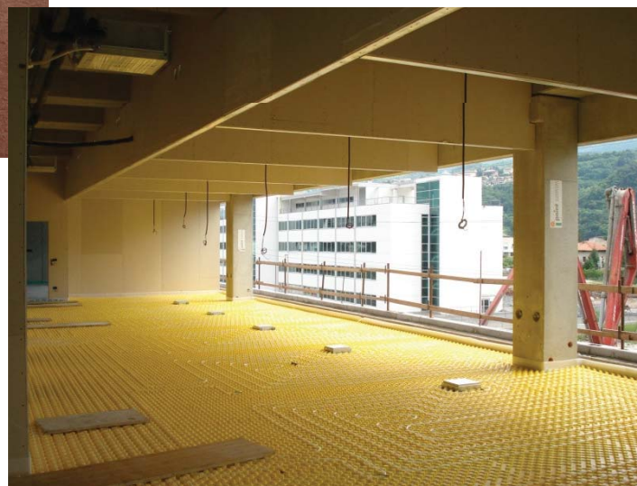
>> Foto 14: Impianti primo piano – 14/07/2011
