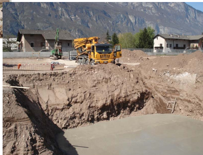
>> Foto 4: Realizzazione fondazioni – 01/04/2011
