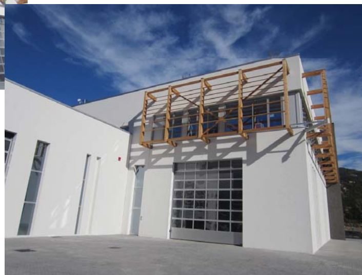
>> Foto 22: Fine lavori – 12/10/2011
