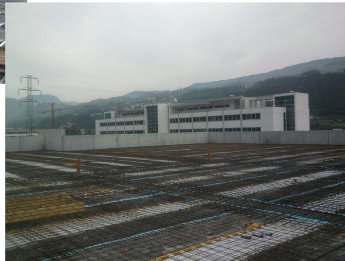
>> Foto 10: Realizzazione solaio copertura – 12/05/2011
