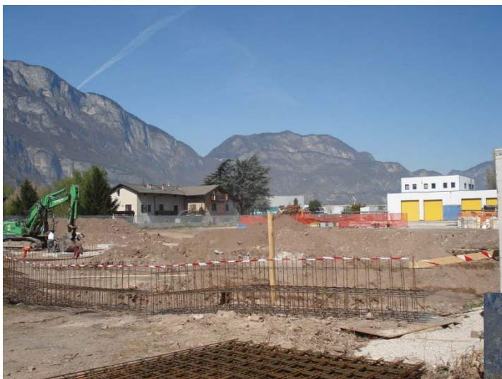
>> Foto 3: Realizzazione fondazioni – 01/04/2011
