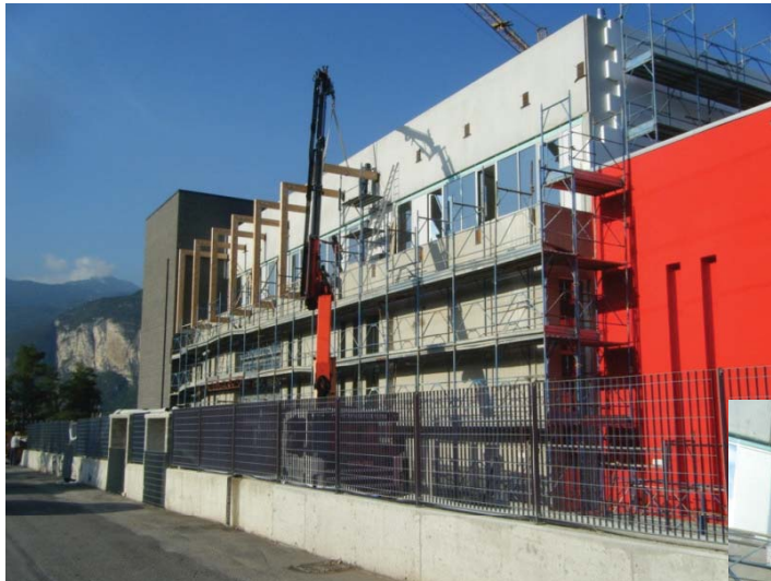
>> Foto 17: Montaggio frangisole – 22/09/2011
