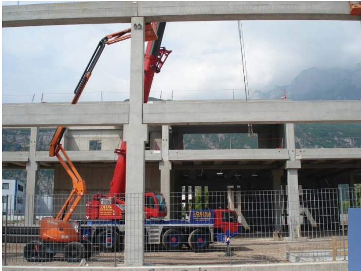
>> Foto 7: Montaggio solai e travi – 02/05/2011
