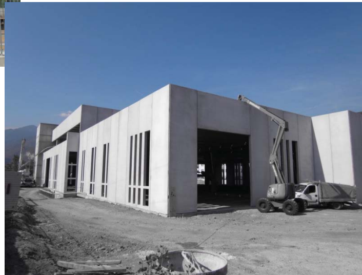
>> Foto 8: Montaggio pannelli prefabbricati– 10/05/2011
