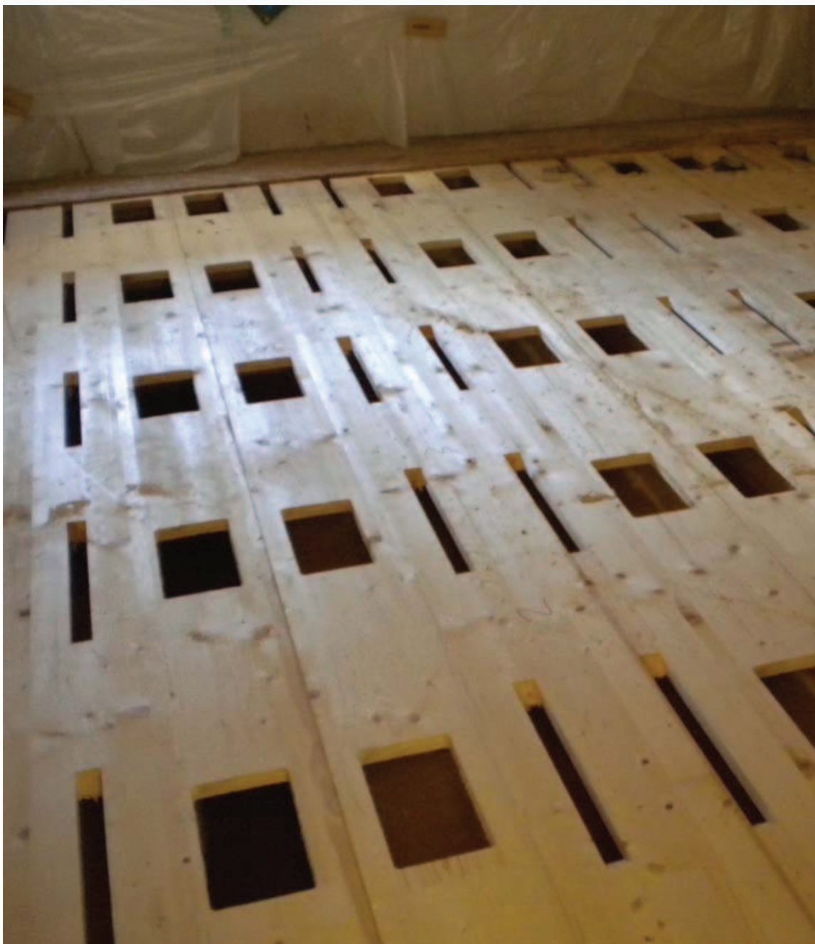
SOLAIO IN LEGNO AD ELEMENTI SCATOLARI REI 60 FONOACUSTICO
