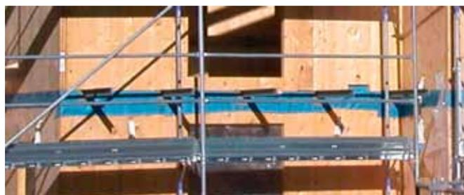
*Solaio e travi per il balcone.*
