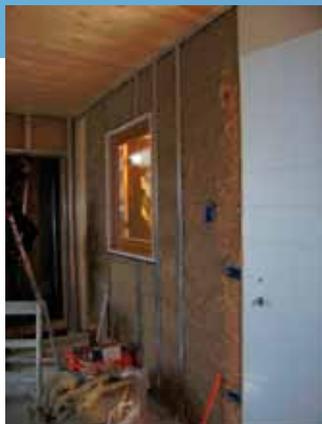
*Coibentazione esterna in fibra di legno (a sinistra), ed isolamento interno in fibra di lino (a destra), durante la posa.*
