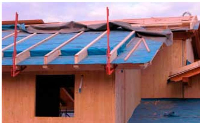
*Posa della coibentazione in fibra di legno sulla struttura del tetto.*
