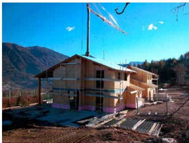
Vista del cantiere, mostra la struttura del telaio in legno.
