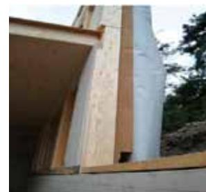
*Costruzione in legno standard con isolamento in fibra di legno sulla parte esterna.*
