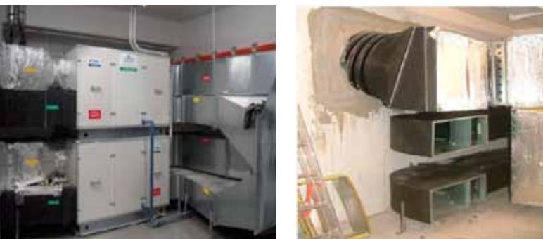
*Unità centrale del sistema di ventilazione con condotti dell'aria.*
