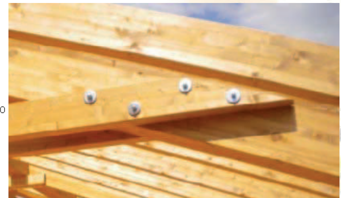
Collegamento puntone catena CAPRIATA TIPO 1 e 3 - Scala 1:20
