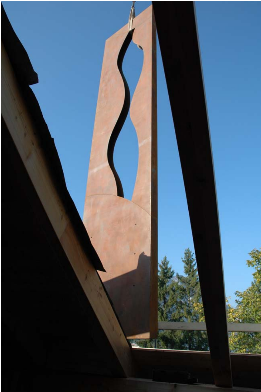
Elemento strutturale corpo scale in acciaio cor-ten
