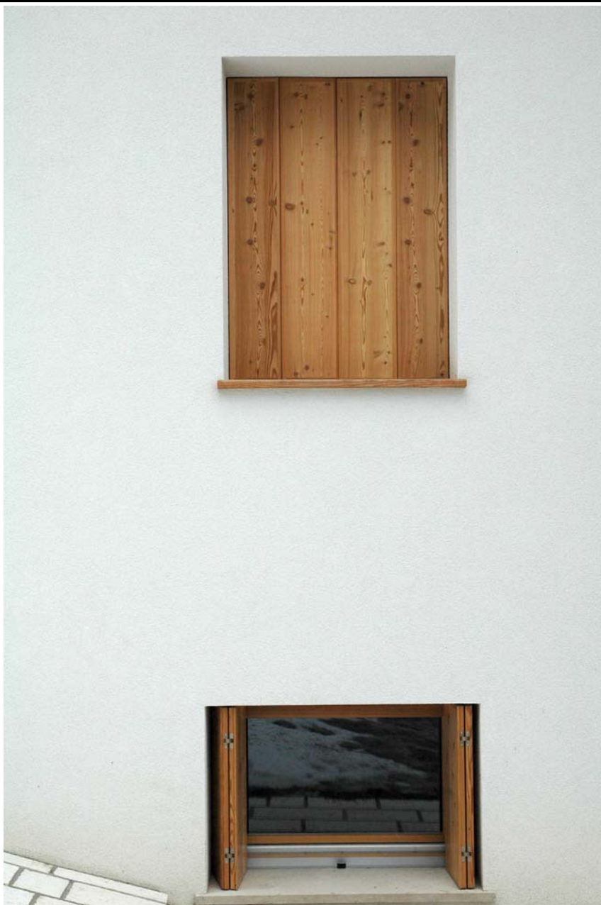
dettagli dell'infisso in larice: oscuri con cerniere invisibili
