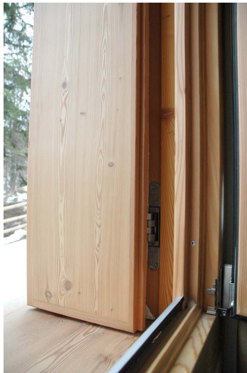
dettagli dell'infisso in larice: oscuri con cerniere invisibili
