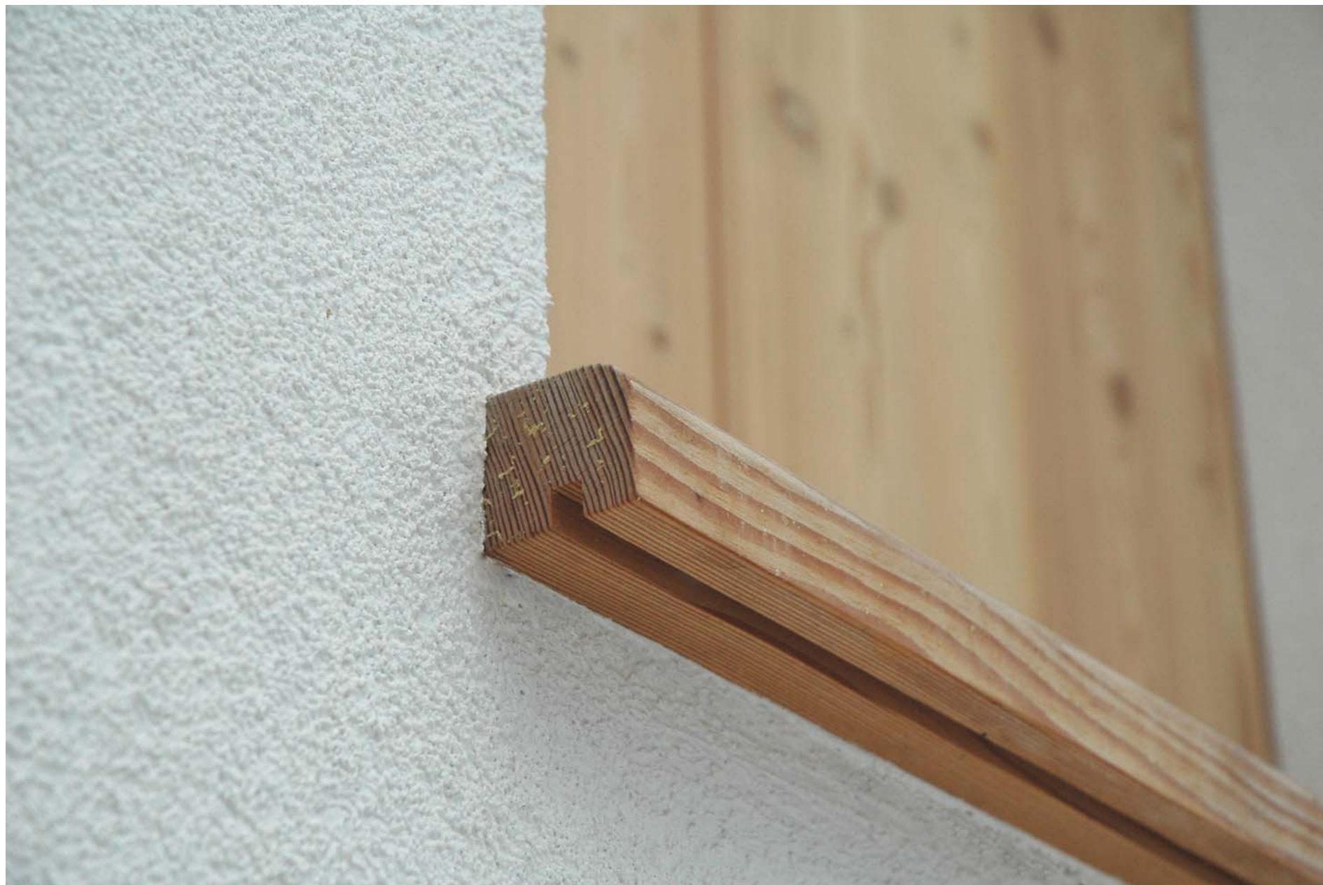
dettagli del bancale in larice: gocciolatoio
