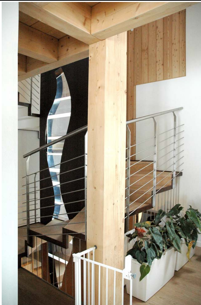
Sistema illuminazione scale con pannello in plexiglas sabbiato e stringa a led
