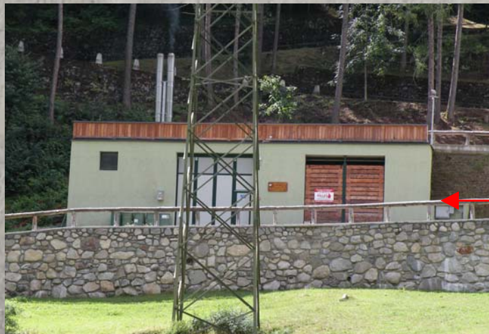
Centrale termica a biomassa
