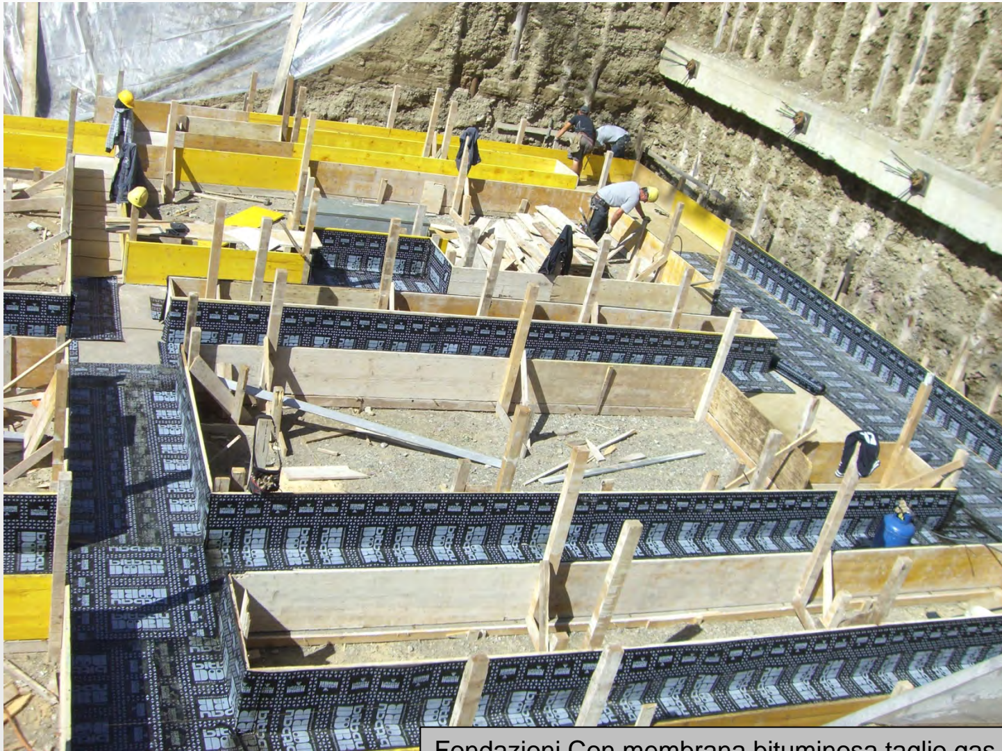
Fondazioni Con membrana bituminosa taglio gas radon
