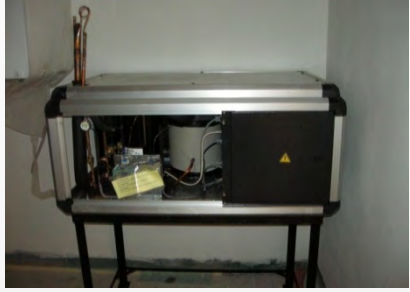
Pompa di calore spilita con assorbimento elettrico di 3,9 kW e con potenza calorifica di 13,6 kW
