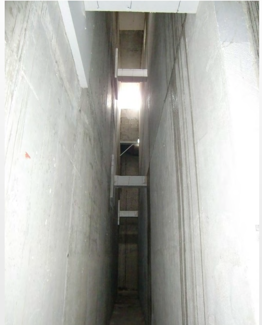
Cappotto vano ascensore e tagli termici intercapedine
