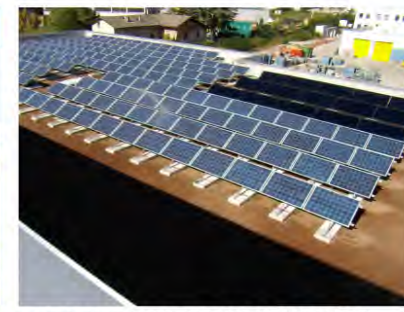
>> FOTO PANNELLI FOTOVOLTAICI
