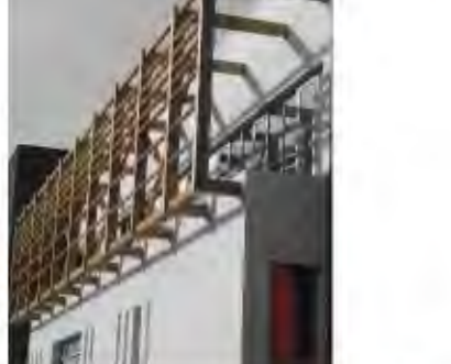
>> FOTO PARTICOLARE FRANGISOLE
