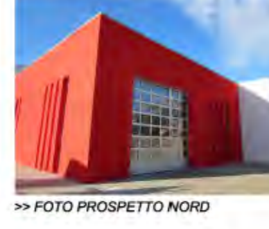
>> FOTO PROSPETTO NORD
