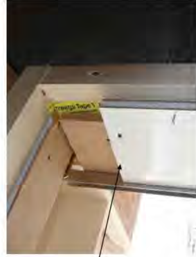
PROVA DI MONTAGGIO
